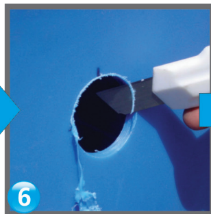
6 Se debavurează gaura finishing the hole/ обрезка
