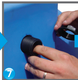
7 Se montează kitul niplu- piulița mounting the connector/ монтаж соединителя
